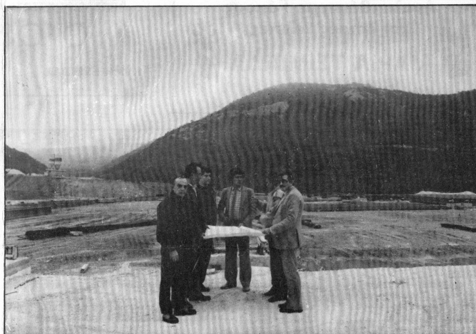
Συζήτηση στον τόπο του έργου μεταξύ του Διευθυντή Διοικητικού της ΕΒΟ κ. Χατήρα, του εργολάβου κ. Ορφανού, του υπεύθυνου για το πρώτο δείγμα κ. Συμεωνίδη, του εκπροσώπου της γερμανικής εταιρείας εγκατάστασης των μηχανημάτων κ. Παναγιωτακόπουλου, του Δημάρχου κ. Θεοδώρου και του εμπορικού αντιπροσώπου της ΕΒΟ κ. Νικολή.
