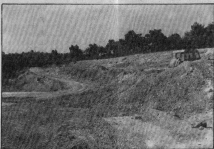
Άποψη του εργοταξίου της ΚΟΙ.Σ.Ε.ΛΙ.Κ. στη λιγνιτοφόρο θέση «Χαροκόπος»
